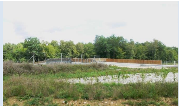
Im Vordergrund, junge Pflanzungen, welche die Überführung mit dem nahen Wald verbinden sollen
