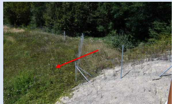
Negatives Beispiel : Der Zaun weicht am Böschungsfuss ab und bildet einen tiefen Punkt, der von Fledermäusen leicht überflogen werden kann
