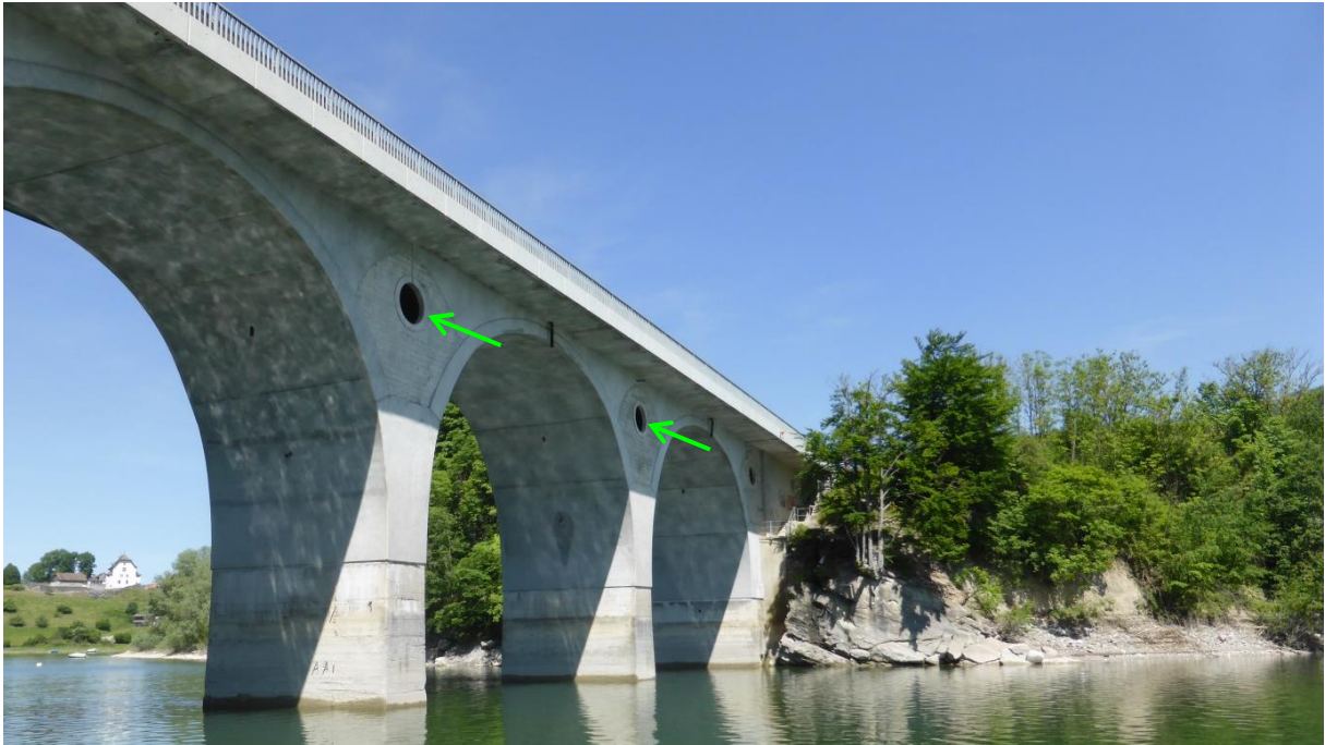
Die Brücke von Corbières beherbergt die grösste Mausohrkolonie des Kantons Freiburg. Pfeile markieren Ein- und Ausflugsstellen, Hangplätze sind im Hohlkörper der Brücke (© Jérôme Gremaud).
