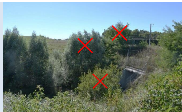
Entwicklung von grossen Bäumen in der Leitstruktur und Büsche auf den Böschungen bewegen Fledermäuse dazu, die Infrastruktur eher zu überfliegen als die Unterführung zu nutzen; verhindern dass Büsche den Eingang des Bauwerkes versperren
