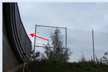
Vermeidung von Lücken bei den Übergängen zu den Querungsbauten
