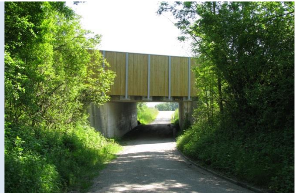
Seitlicher Blendschutz aus Holz, der es erlaubt einen Flugkorridor im Dunkeln zu halten
