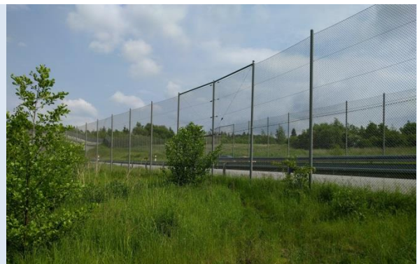
Gitterzaun, welcher Fledermäuse zu einem Querungsbauwerk führt
