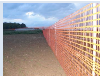
Einsatz von temporären Leitstrukturen (Plastikzaun) in der Bauphase
