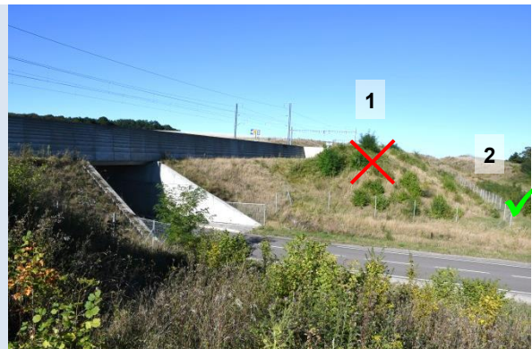
Die sich entwickelnden Sträucher im oberen Teil der Böschung könnten Fledermäuse dazu bewegen die Bahngeleise zu überfliegen (1); die Sträucher am Fusse der Böschung, ausserhalb des Zauns (2), leiten die Fledermäuse zum Eingang der Unterführung
