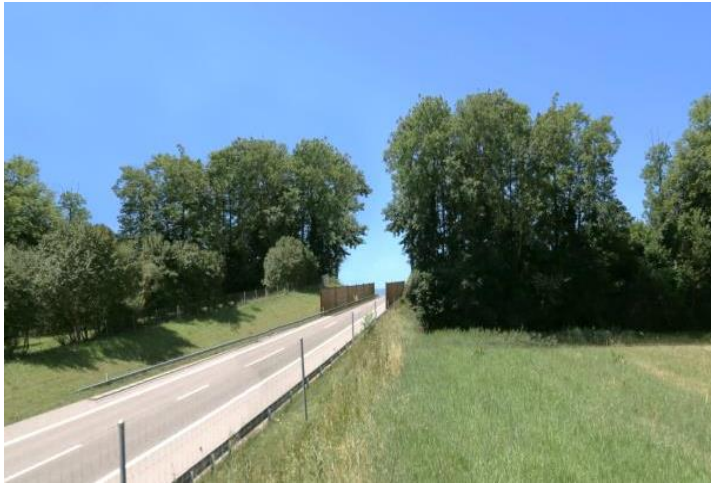
Abbildung 20: Hop-over, verstärkt mit einem Holzzaun, leitet die Fledermäuse über dem Verkehr durch (Fotomontage).
