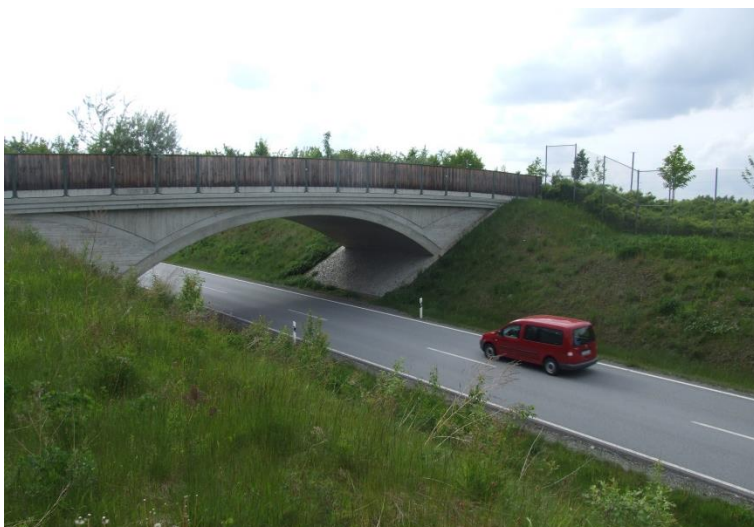
Abbildung 14: Brücke für landwirtschaftliche Fahrzeuge, aufgewertet um den Fledermäusen die Überquerung zu erleichtern (Zaun, Blendschutz aus Holz, Pflanzung von Leitstrukturen) Staatsstrasse S170n, Bahretal, Sachsen, Deutschland.
