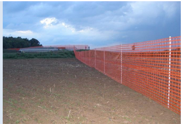
Temporäre Leitstruktur erstellt aus 2m hohen Bauzäunen aus Plastik; dieser Zaun wurde auch auf dem Querungsbauwerk aufgestellt, solange die gepflanzte Vegetation noch nicht genug entwickelt war
