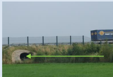
Heckenleitstruktur zur Unterführung Hamco Borna
