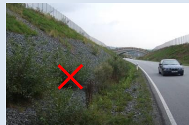
Gehölze strassenseitiger Raum entfernen
