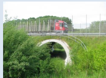
Enge Anbindung der Leitstruktur an die Unterführung
