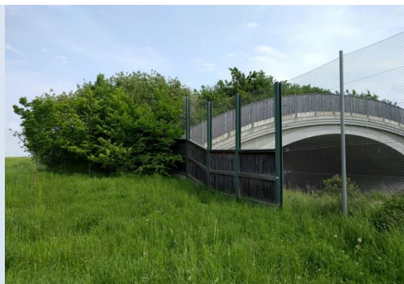
Clôture de 3 m de hauteur reliée aux écrans latéraux d'un passage supérieur
