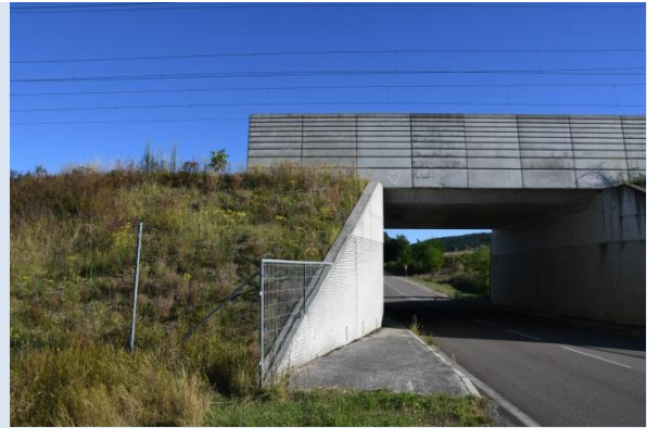
Raccordement de la clôture au pied de l'entrée d'un ouvrage de franchissement inférieur
