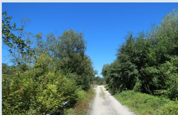
Haie double guidant les chauves-souris vers un ouvrage de franchissement supérieur autoroutier
