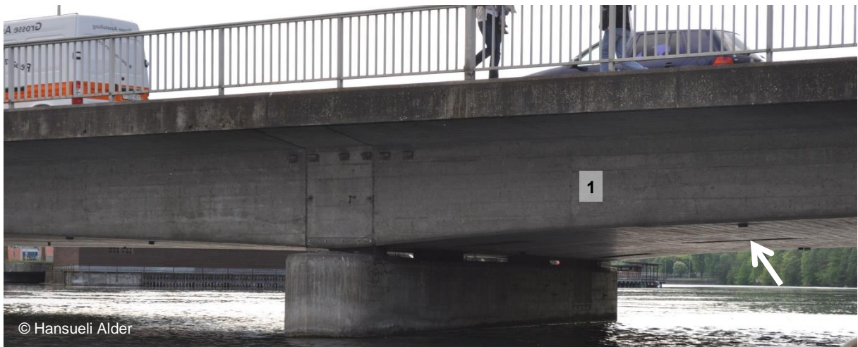
Le tablier creux (1) de ce pont est occupé par des chauves-souris. La flèche indique l'orifice d'accès, voir détails au point 3.
