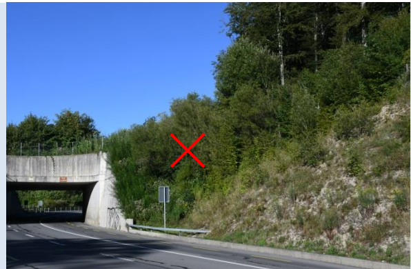
Le développement de buissons sur le talus entre la clôture et la chaussée guide les chauves-souris hors du passage supérieur et augmente fortement le risque de collision
