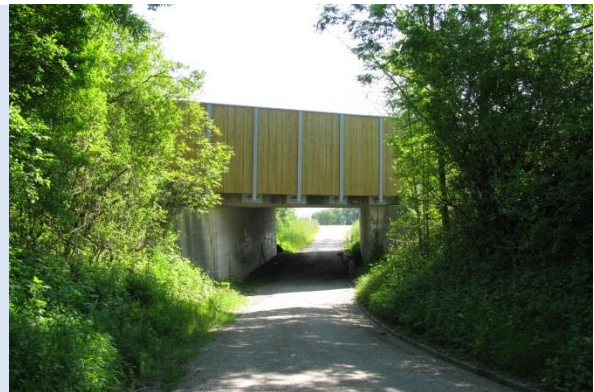
Ecran latéral opaque en bois permettant de maintenir une route de vol dans l'obscurité
