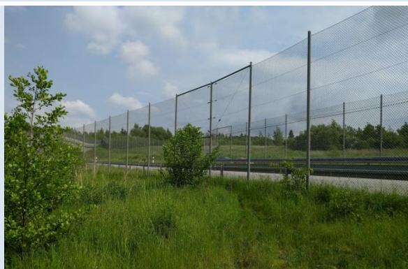
Clôtures grillagées guidant les chauves-souris sur un ouvrage de franchissement (au fond à gauche)
