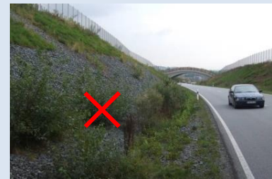
Elimination des buissons sur les accotements routiers
