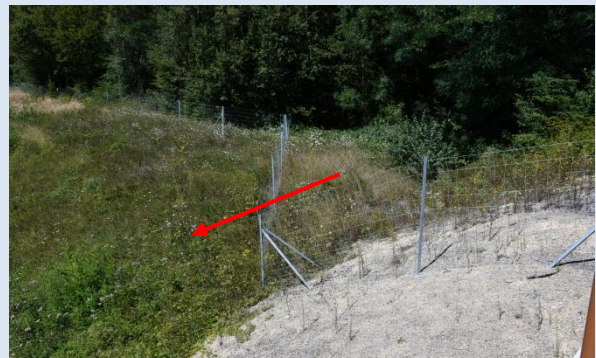
Exemple négatif : la clôture fait un décrochement au pied du talus bordant un passage supérieur, créant un point bas aisément franchissable par les chauves-souris
