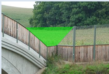
Obturation des points bas entre les palissades opaques et les clôtures
