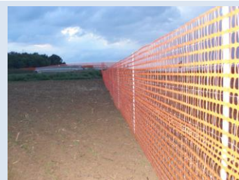
Utilisation de structures guides provisoires (clôture en plastique) durant la phase de construction
