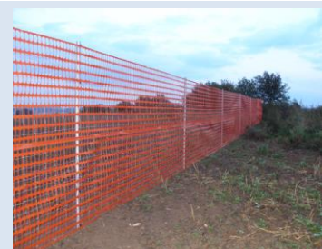
Utilisation de clôtures de protection provisoires lors de la phase de construction
