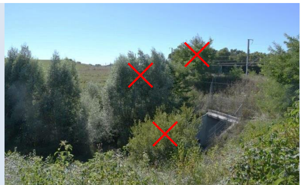
Le développement de grands arbres au sein de la structure guide et de buissons sur le talus incite les chauves-souris à survoler l'infrastructure plutôt que d'emprunter le passage inférieur ; éviter que des buissons obstruent l'entrée du passage
