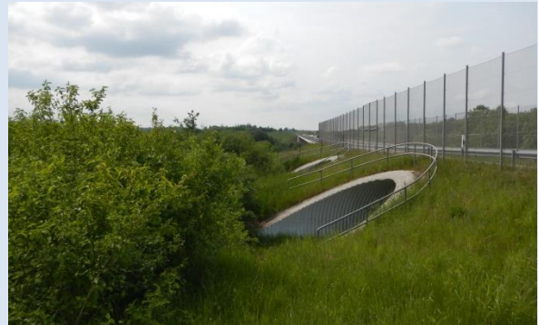
Clôture incitant les chauves-souris à emprunter le passage inférieur ou à franchir la route au-dessus de la circulation
