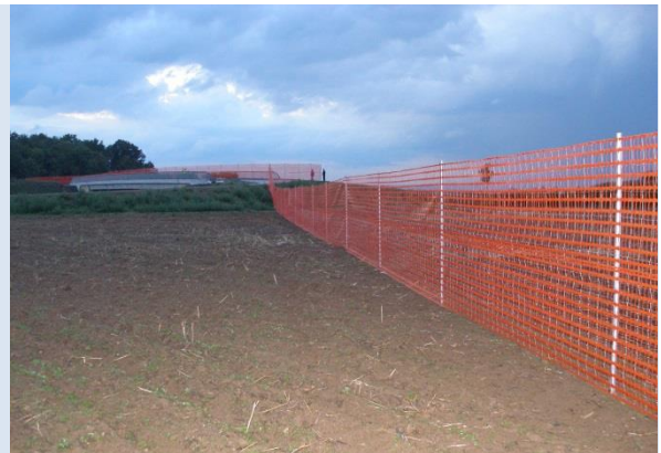
Structure guide temporaire réalisée à l'aide de 2 hauteurs de clôtures de chantier en plastique ; la clôture a également été posée sur l'ouvrage de franchissement, dans l'attente du développement des plantations
