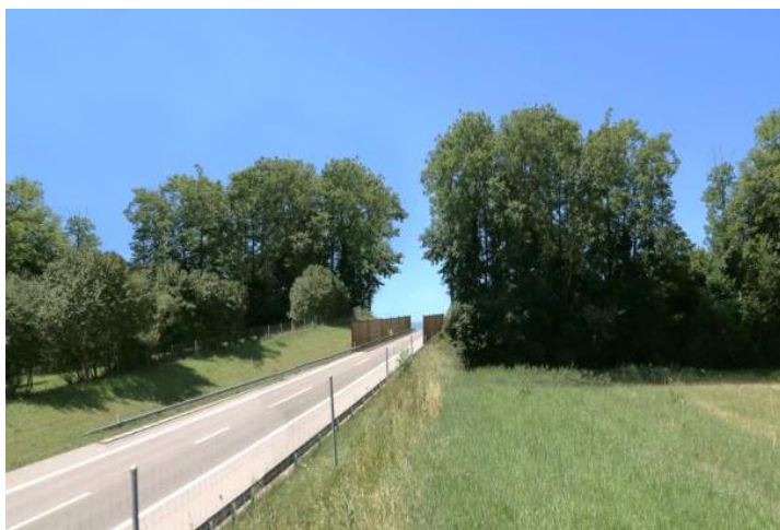
Figure 20: Tremplin vert renforcé d'une palissade en bois obligeant les chauves-souris à s'élever au-dessus du trafic (photomontage).
