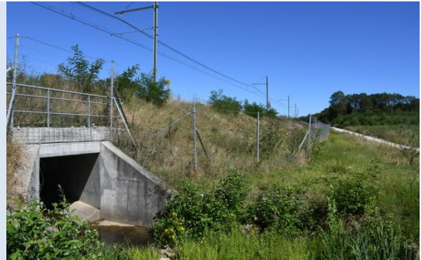
Les clôtures contournent l'ouvrage par le haut et guident les chauves-souris à l'intérieur du passage inférieur
