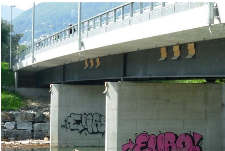
Figure 17: Nichoires à chauves-souris installés sur une poutre métallique d'un pont moderne enjambant un cours d'eau (© Marzia Mattei).
