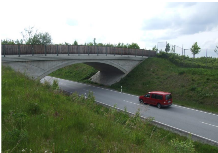
Figure 14: Pont utilisé pour le passage du trafic agricole, aménagé pour permettre le franchissement des chauves-souris (clôtures, palissades en bois opaques, plantations de structures guides), Staatsstraße S170n, Bahretal, Sachsen, Allemagne.
