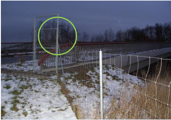
Exemple positif : insertion correcte d'un grillage à l'entrée d'un ouvrage de franchissement
