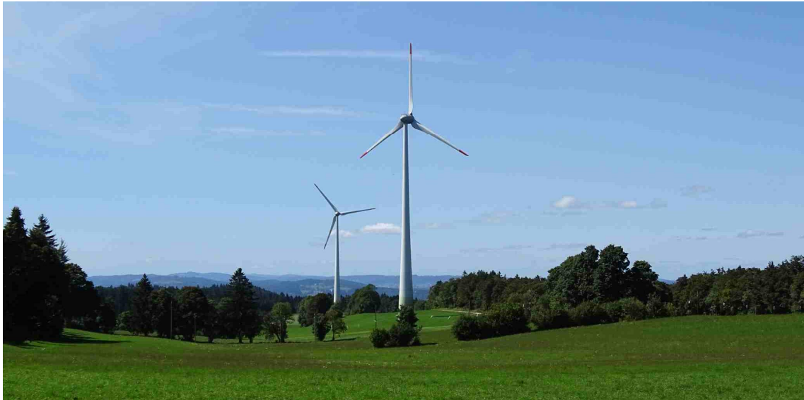
Abb. 1. Zwei der drei WEA im Windpark bei Le Peuchapatte (Blickrichtung Südwest). Die WEA am Standort 2 befindet sich rechts im Bild (Standort Zentrum des Windparks), die WEA am Standort 3 befindet sich links im Bild (Standort West des Windparks). (Foto: Schweizerische Vogelwarte Sempach, 25.08.2015).
